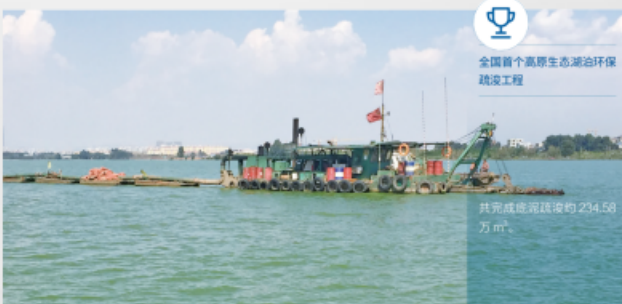
云南省滇池底泥环保疏浚工程
