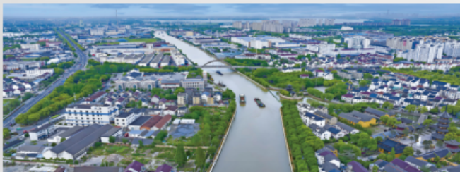
湖嘉申线湖州段航道建设工程
