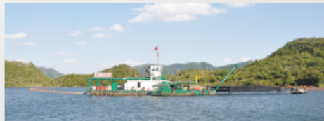
浙江省浦江通济桥水库生态清淤工程
