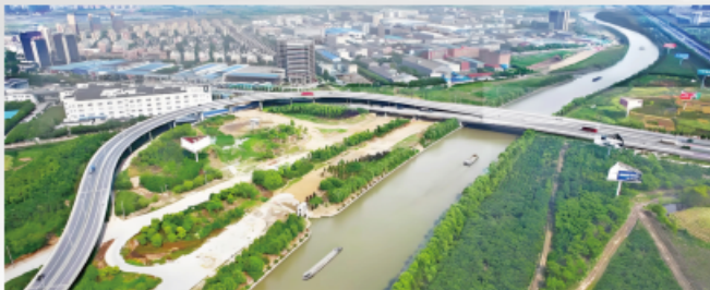
嘉于陕线航道改造项目南郊河工程
